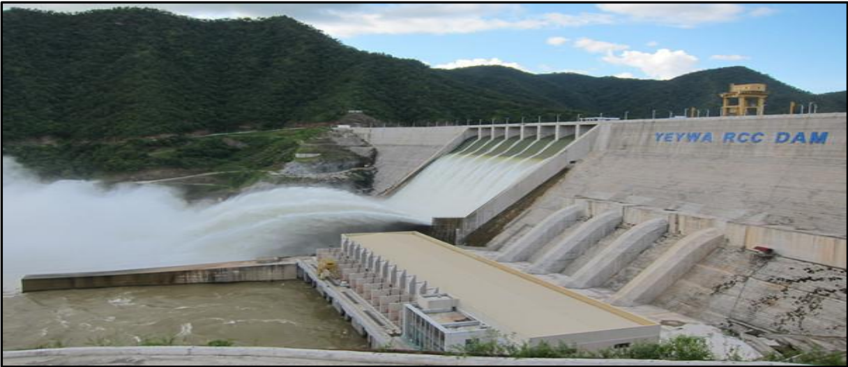
ပုံ(၄)။ ရဲရွာRCC (Roller-compacted concrete)ဆည် ၂၂
